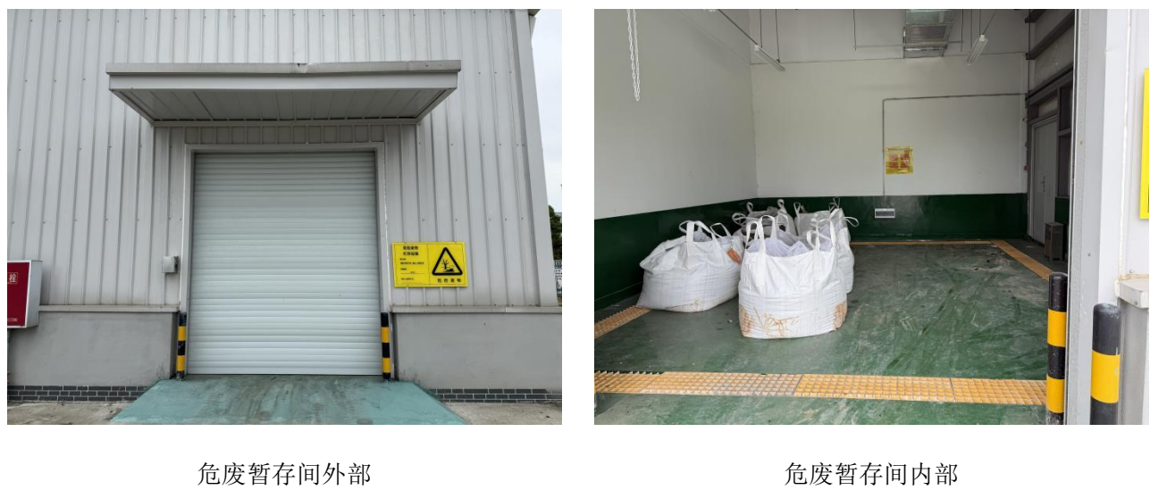
图 2.4-3 已建危废暂存间
