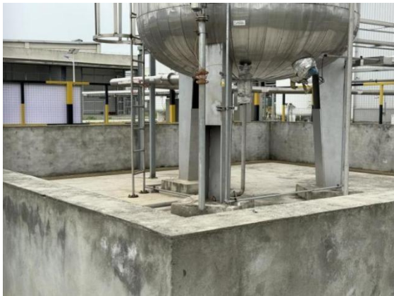
罐区围堰及导流沟
