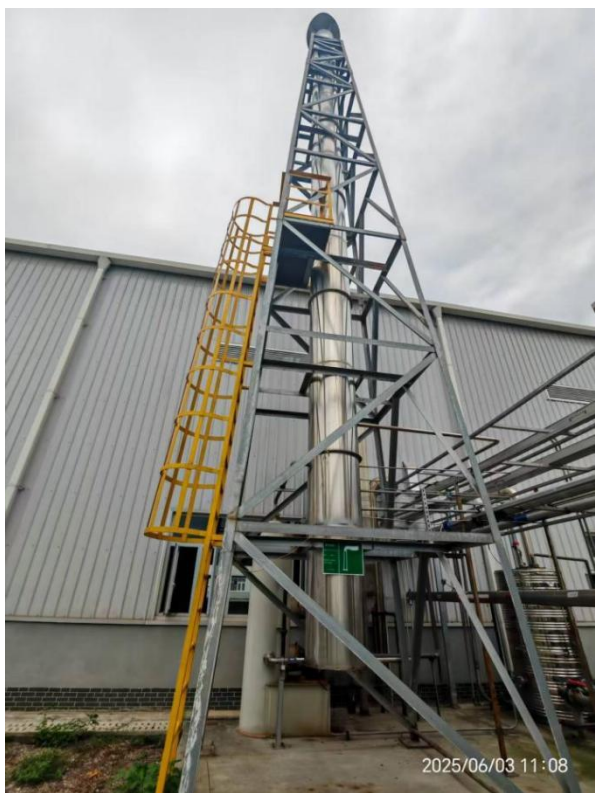
氧化亚氮生产线排气筒（P1）
