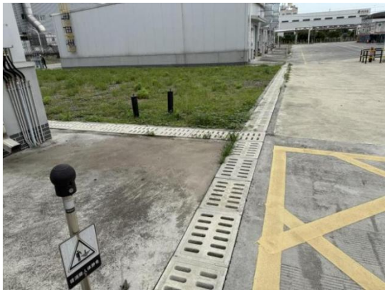
库房四周收集水沟
